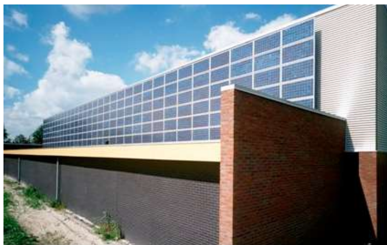
Voorbeeld zonnepanelen aan gevels.
