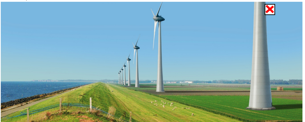
Lijnopstelling langs zeewering of landinwaarts in de vensters
